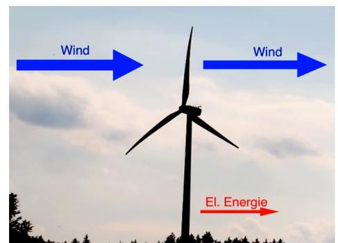
2) **Energieumwandlung an einer Windkraftanlage** Um die kinetische Energie der Luft zu berechnen, die die Windkraftanlage in Bewegung setzt, benötigt man die Masse der Luft.
